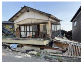
能登地震で一階が押しつぶされた家(珠洲市蛸島町)
